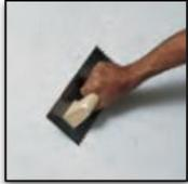
1) Peinado Cemento cola (llana dentada 2-3mm). Se recomienda la utilización de adhesivos específicos para la instalación de materiales de absorción nula.
