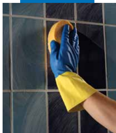
Limpieza y acabado con esponja dura de celulosa
