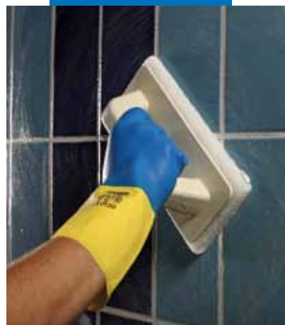
Kerapoxy CQ se emulsiona con agua, utilizando una esponja Scotch-Brite®
