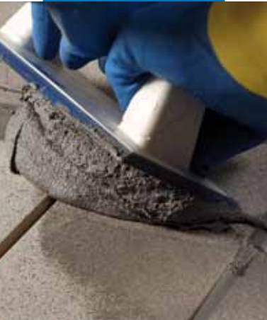
Aplicación de Kerapoxy CQ con llana MAPEI
